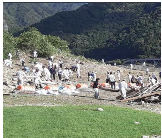
流木搬出作業状況
