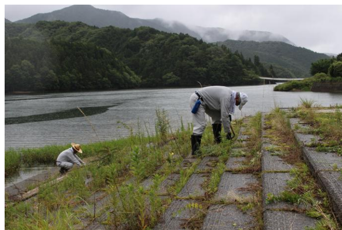
作業状況(背面はダム湖)
