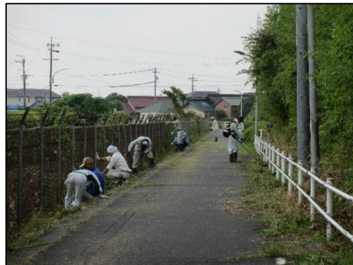
下流部での作業風景
