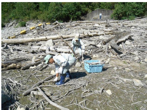
流木搬出作業
