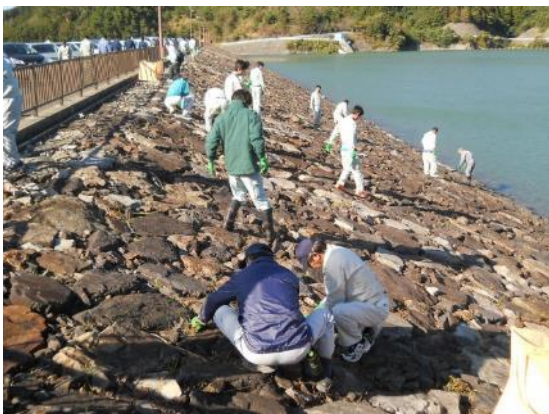
堤体貯水池側法面作業状況
