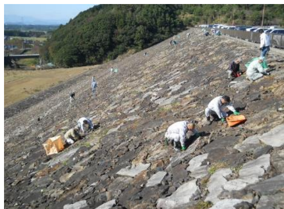
堤体下流側法面作業状況
