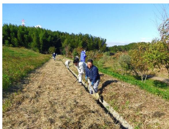
作業風景・側溝の土砂
