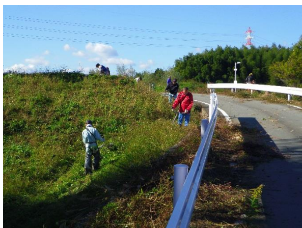
作業風景・法面の草
