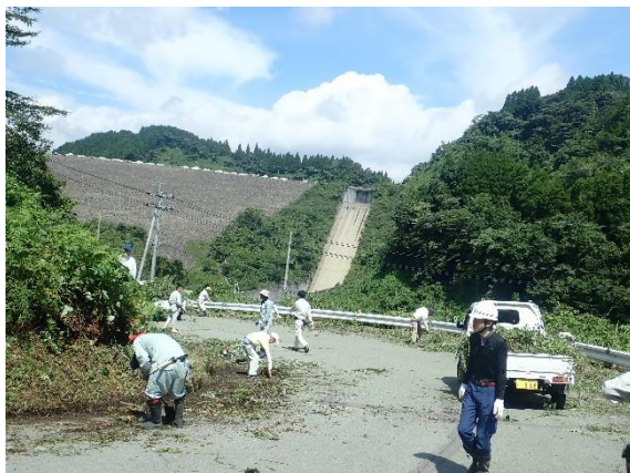
ダム直下での土砂上げ作業
