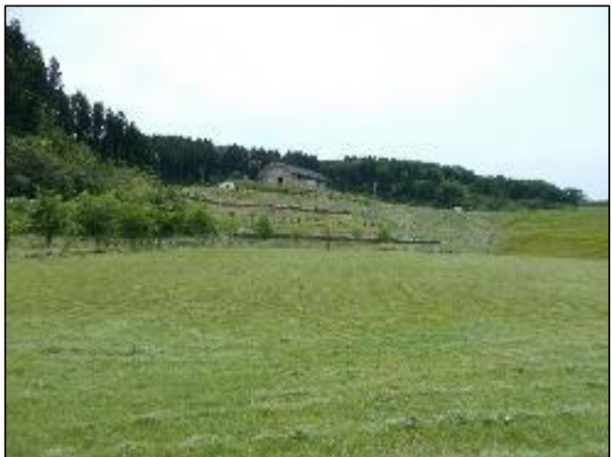
すっかり綺麗になった堤体(下流部より)
