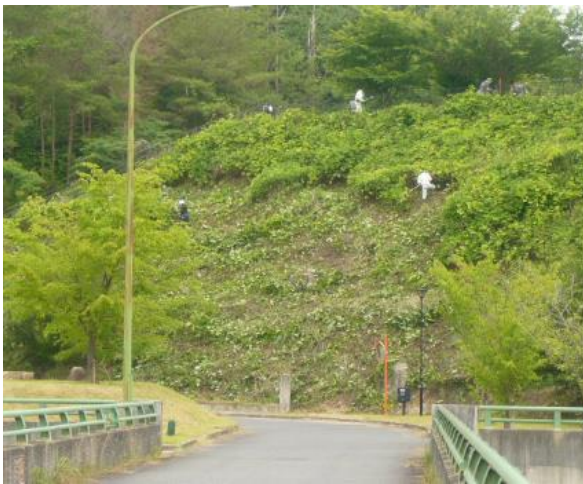
ダム左岸法面作業状況
