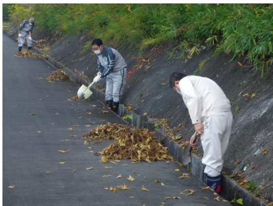
作業風景・道路側溝の土砂上げ（管理用）
