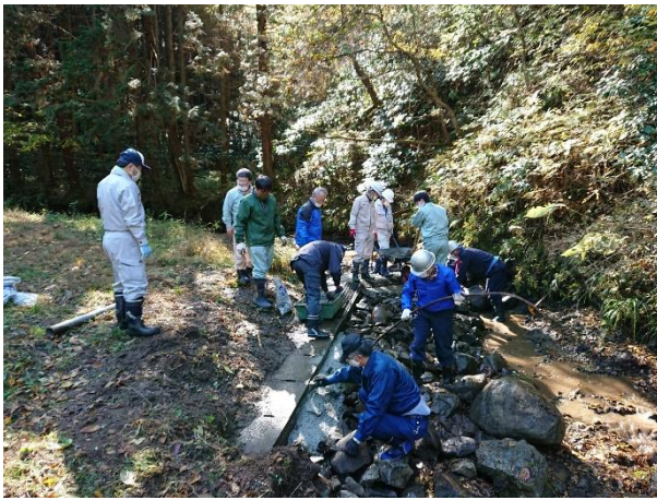
取水口の補強作業をする参加者
