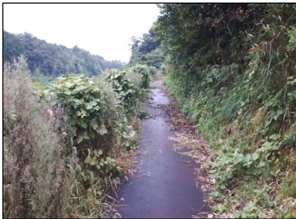
調整池管理用道路(作業前)
