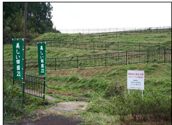
調整池正面の法面(作業後)
