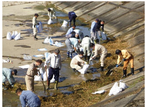
作業風景・洪水吐部の土砂上げ（第2副）
