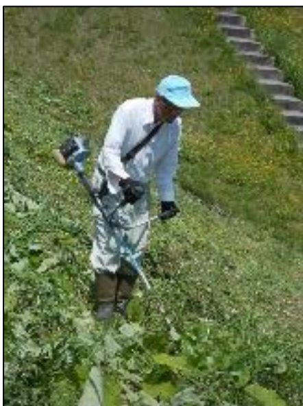
急傾斜地での作業
