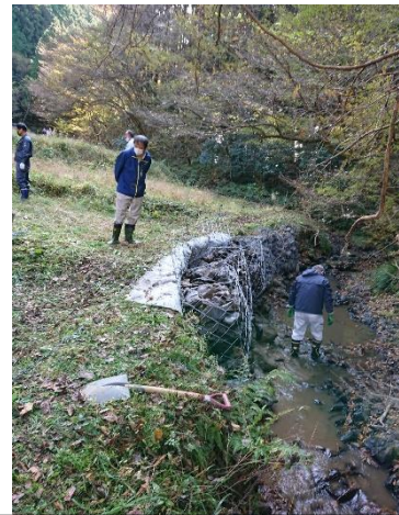
法面の補強作業をする参加者
