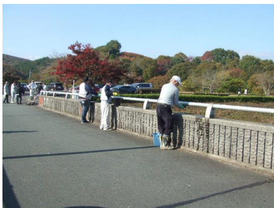
ダム高欄の清掃
