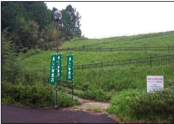
調整池正面の法面(作業前)
