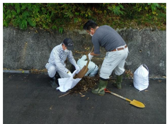
作業風景・道路側溝の土砂上げ（管理用）
