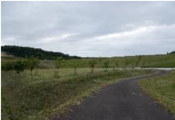
すっかり綺麗になった堤体
