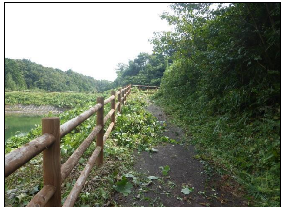
調整池管理用道路(作業後)
