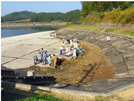
作業風景・洪水吐部の土砂上げ（第2副）
