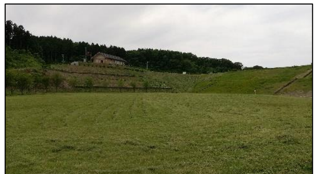
□作業後の堤体下流部(左:管理棟、右:堤体部)
