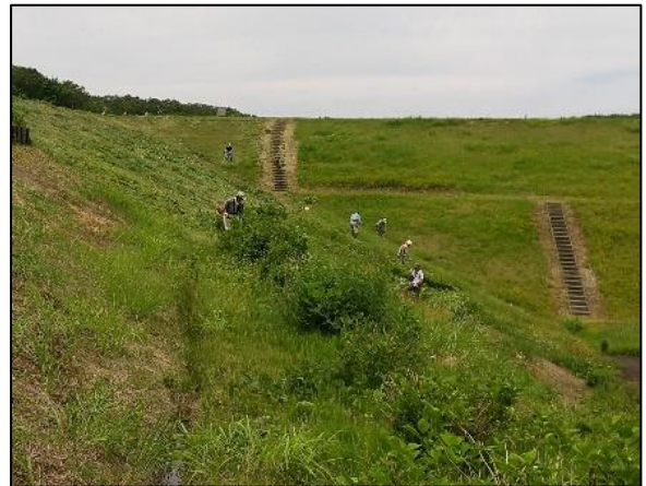
□作業状況(管理棟直下の急斜面)
