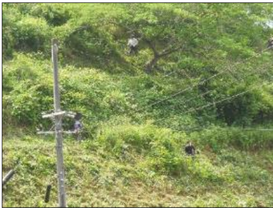
ダム右岸法面作業状況
