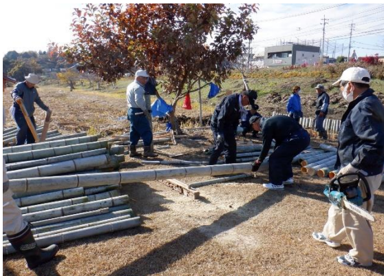
土留め用竹材の加工作業
