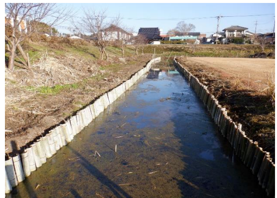
一部完成した蓮池
