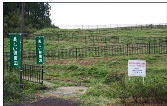
調整池本堤正面の法
