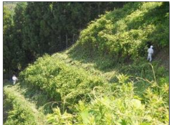
ダム右岸法面作業状況
