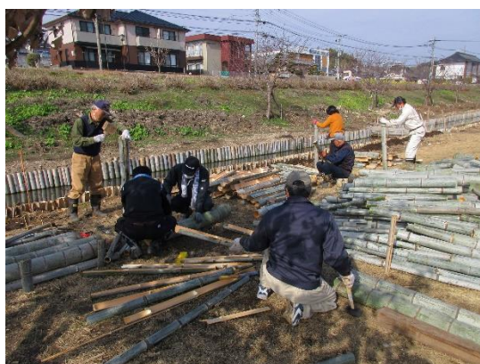
竹材の半割・節取作業
