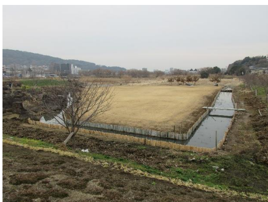
一部完成した蓮池
