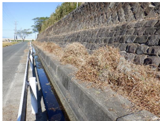
作業後の状況
