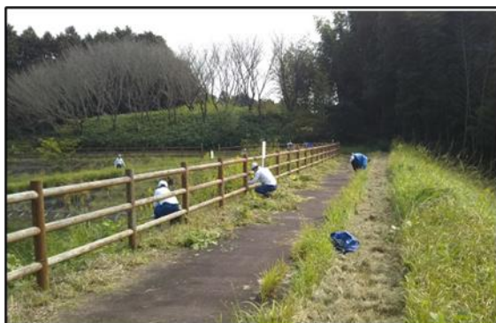
調整池天端の作業状況
