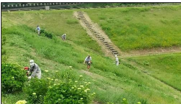
□作業状況(堤体下流部付近)
