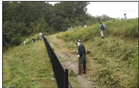
調整池本堤正面の法面作業状況
