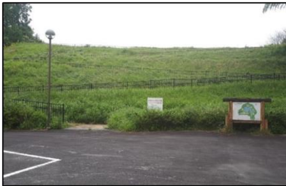
調整池本堤正面の法面（作業前）
